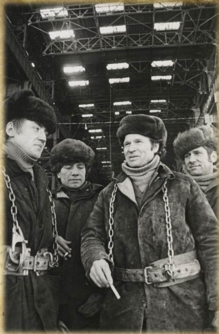
Бригада монтажников треста «Южстальконструкция», возглавляемая А.А. Аношкиным (второй справа), одна из первых начала монтаж корпусов Атоммаша. 1981 год.
